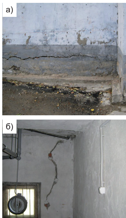
Рис. 1. Фотографии бокового фасада бассейна «Дельфин» (а) и сквозной трещины во внутренней части здания (б)
